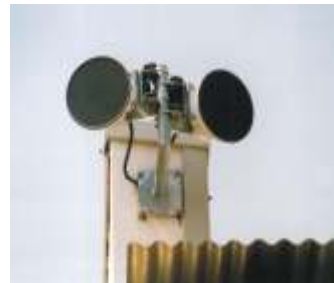
Abbildung 13: Aufbau einer Mikrowellen Richtfunkstrecke ohne direkten Sichtkontakt durch eine Spiegel- oder "Rücken-an-Rücken"-Anordnung
